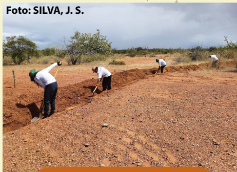
Foto 15: Limpeza e acabamento de cordão em contorno instalado em área de relevo suave e de solo exposto, Curaçá-BA.
