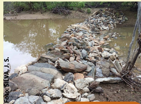
Foto 14: Barragem sucessiva de contenção de sedimentos, Curaçá-BA.
